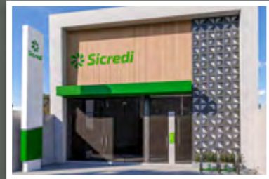
AG. CAMPINA DO MONTE ALEGRE/SP Rua Rocha Miranda, Centro
