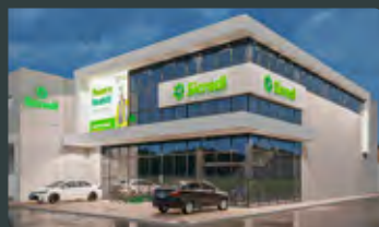
ITAPETININGA/SP Rua Quintino Bocaiúva, 524. Centro.
