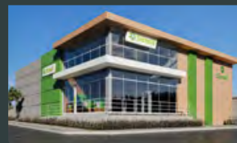
PARANAPANEMA/SP Rua Joaquim Vieira de Medeiros, esq. Rua Bom Sucesso
