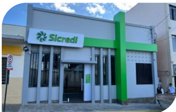
Ponto provisório em Carmo da Mata/MG.
