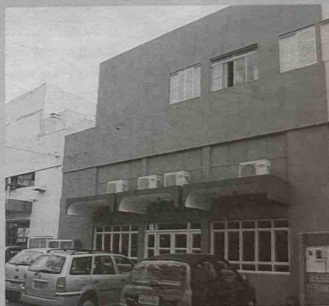
FACHADA DO PRÉDIO DO NOVO ENDEREÇO DA SICREDI CENTRAL MS, NA CAPITAL
