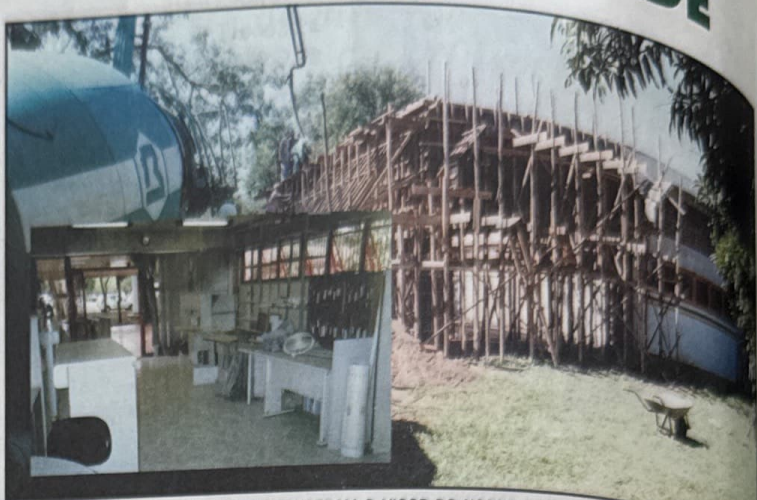
OBRAS DE AMPLIAÇÃO DA SEDE DEMONSTRAM O VIGOR DO NOSSO DESENVOLVIMENTO
