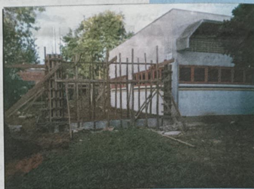
As obras seguem em ritmo acelerado
