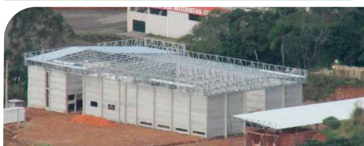
Início da construção da terceira e atual sede, em 2015.
