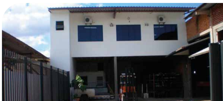
Construção da parte administrativa, em 2008.
