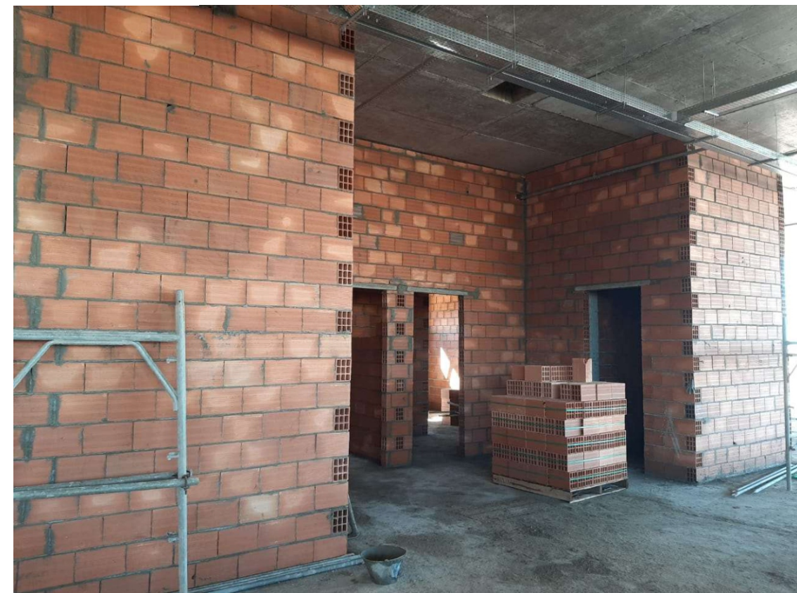
Alvenaria 2º Pav
