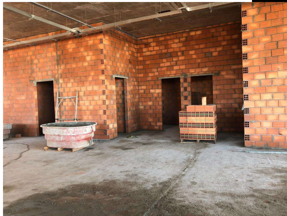
Alvenaria 2º Pav
