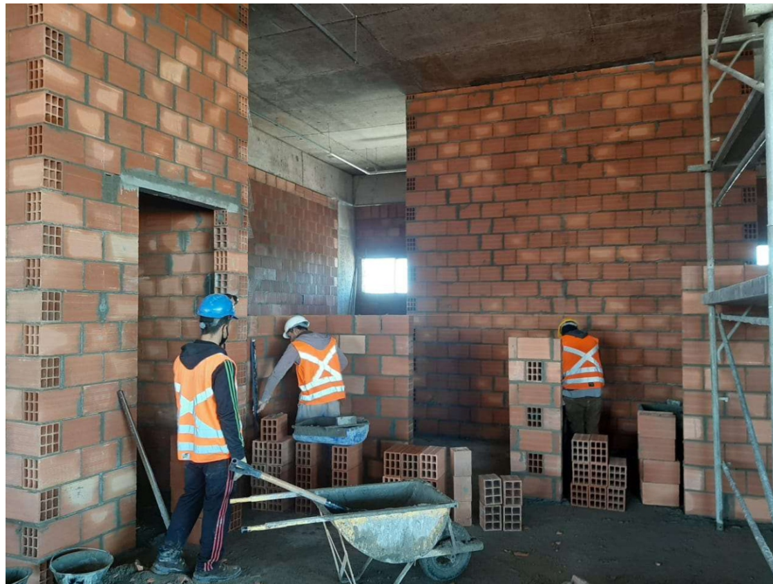
Alvenaria 2º Pav
