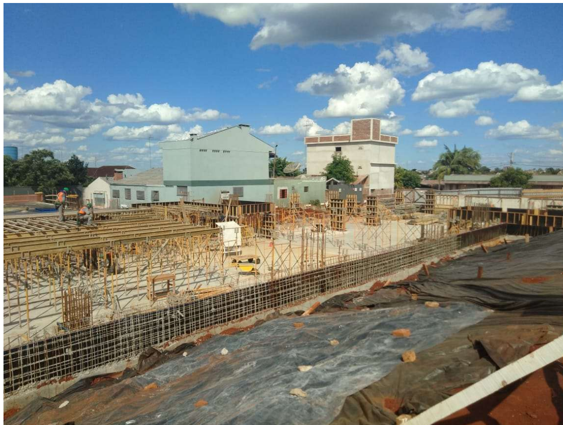
Montagem Escoramento Térreo
