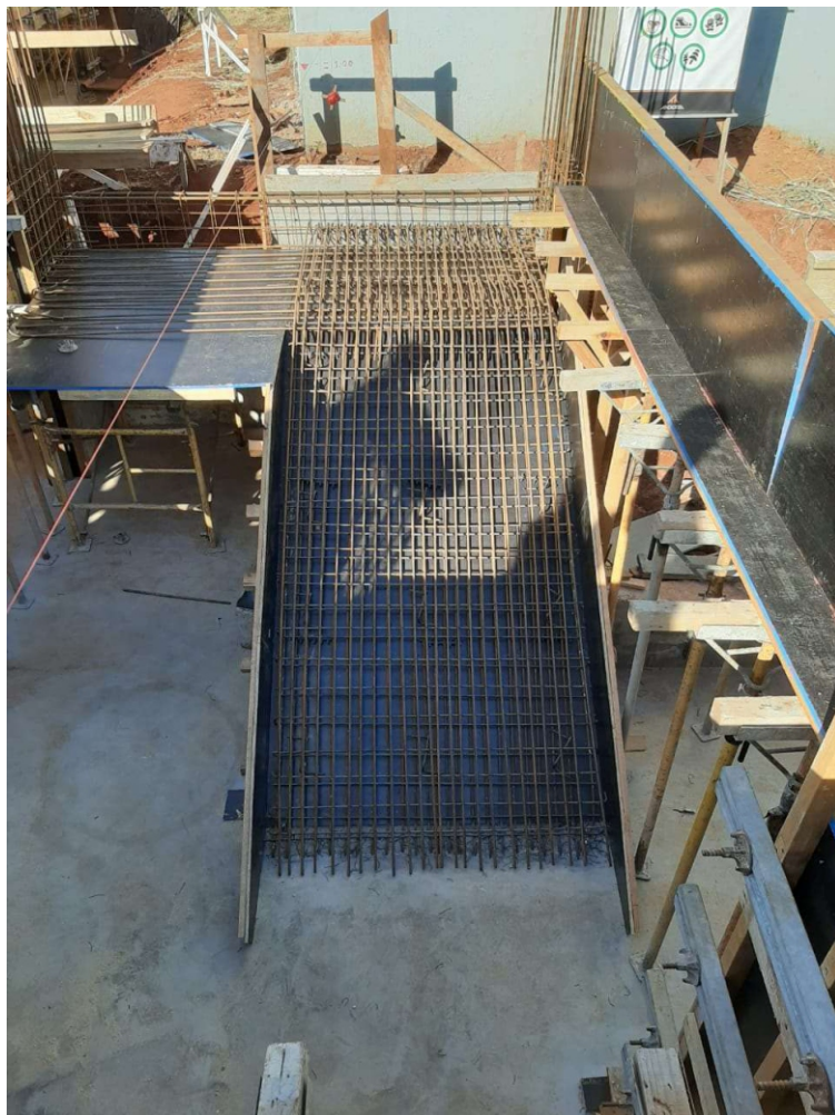
Montagem armadura das escadas e vigas de equilíbrio
