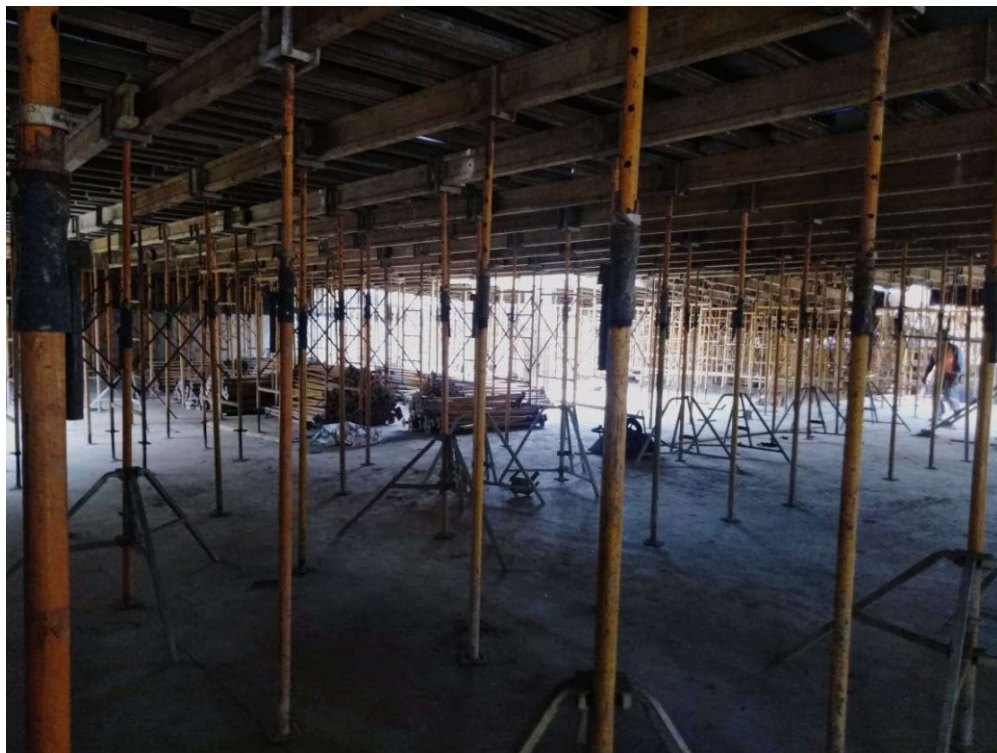
Escoras Laje Térreo / Concretagem Pilares
