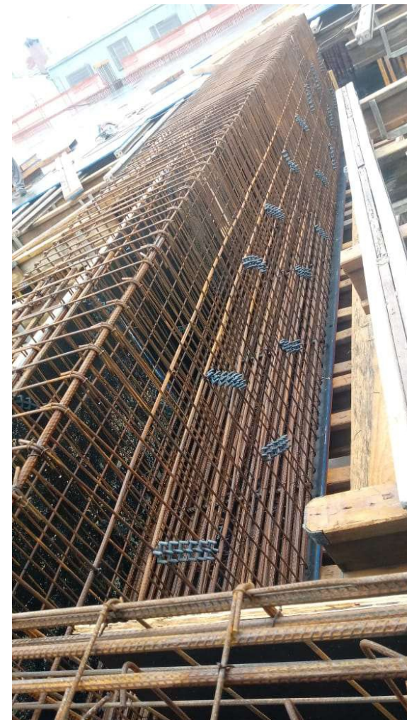
Montagem armadura das escadas e vigas de equilíbrio
