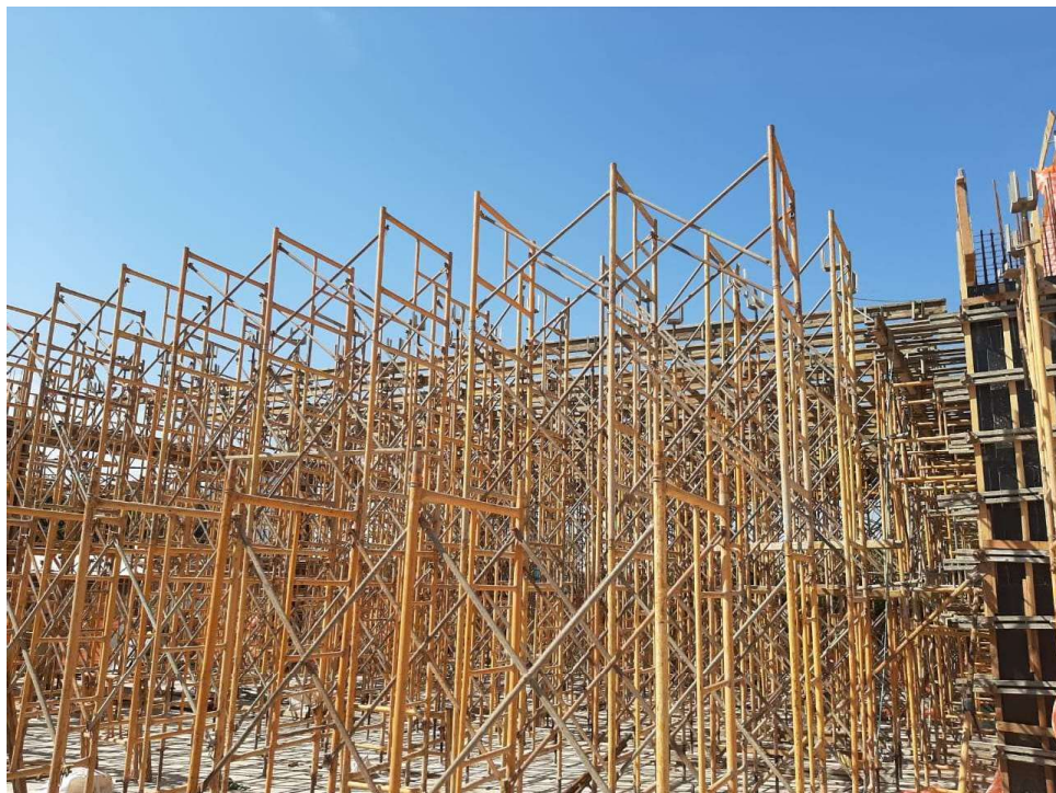
Cimbramento Laje 2º Pav
