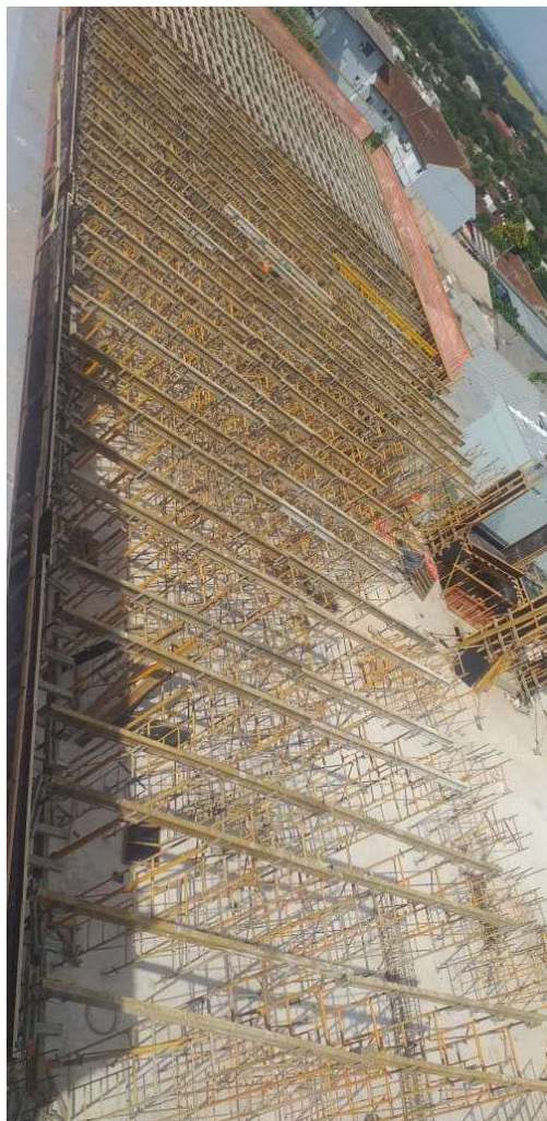
Montagem do Cimbramento da Laje 2º Pav
