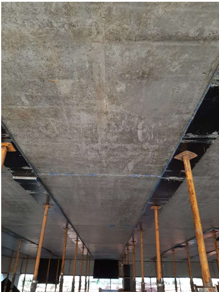
Laje Térreo Desformada
