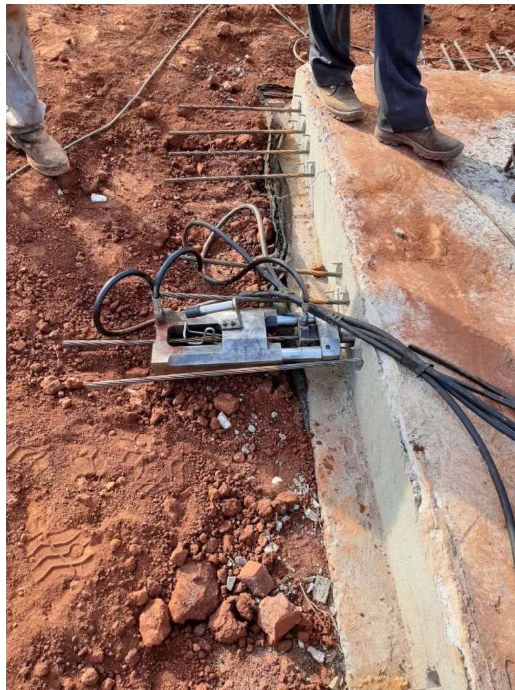
Protensão dos Cabos Transversais
