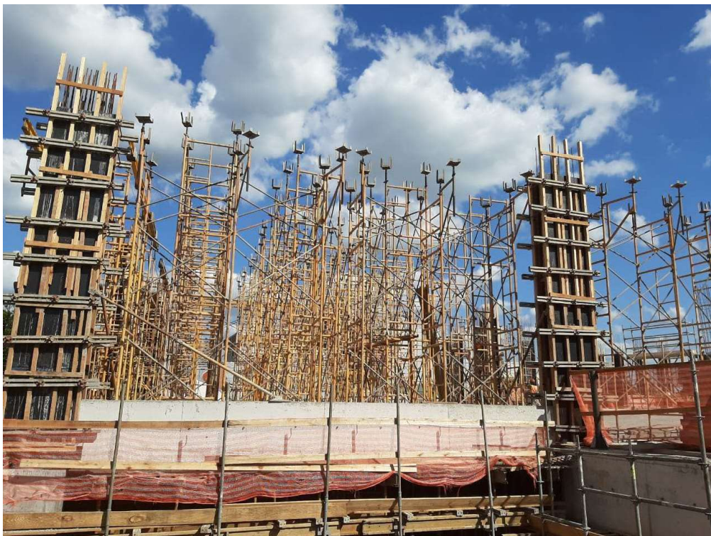
Montagem Cimbramento 2º Pav
