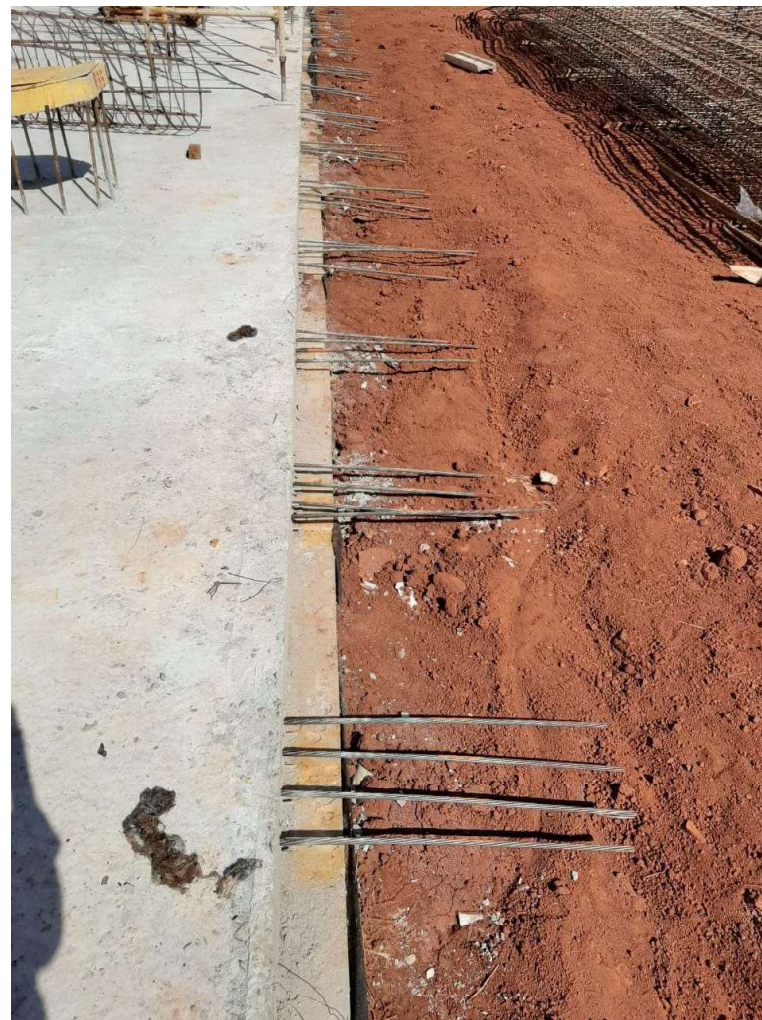
Preparação para Protensão dos Cabos
