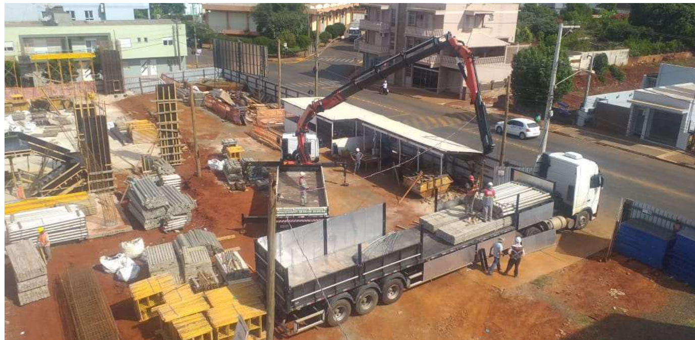
Descarga dos Materiais de Escoramento
