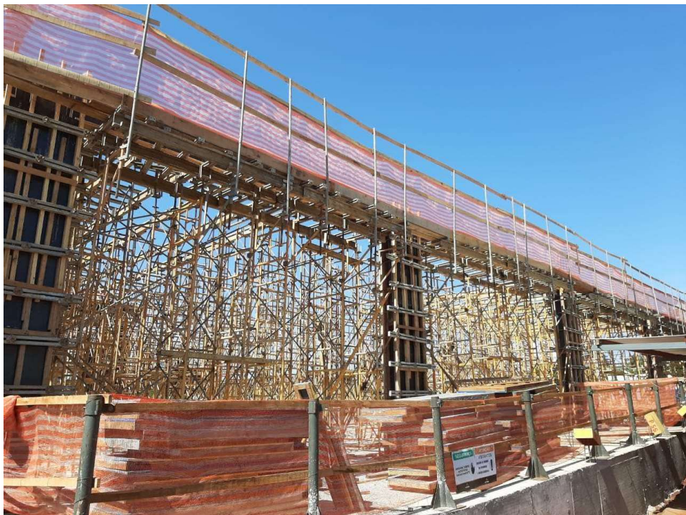
Manutenção Guarda-corpo de Perímetro
