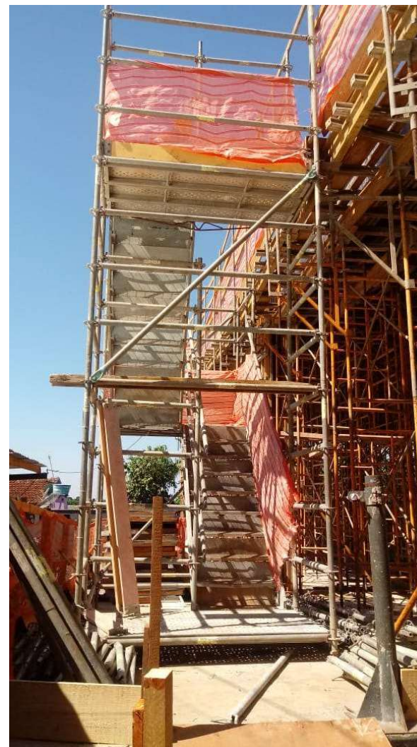
Montagem de Escada Metálica de acesso
