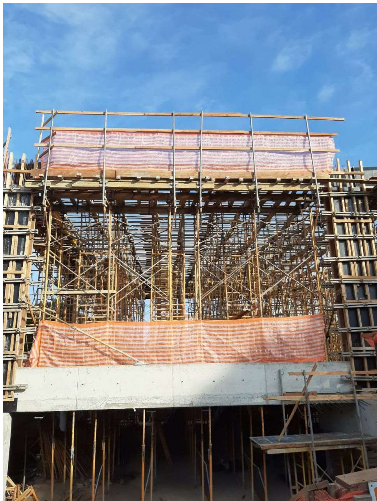
Manutenção Guarda-corpo de Perímetro
