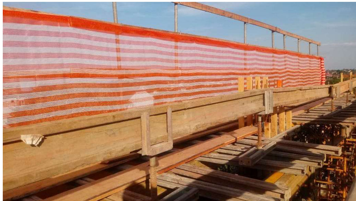
Montagem do Cimbramento da Laje 2º Pav
