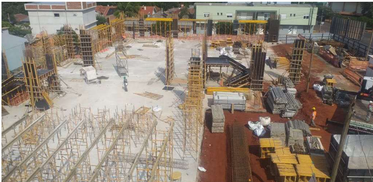
Montagem do Cimbramento da Laje 2º Pav
