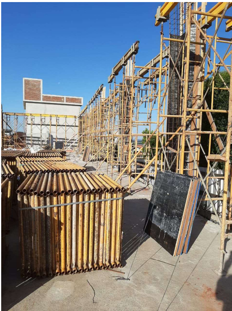
Montagem Cimbramento 2º Pav
