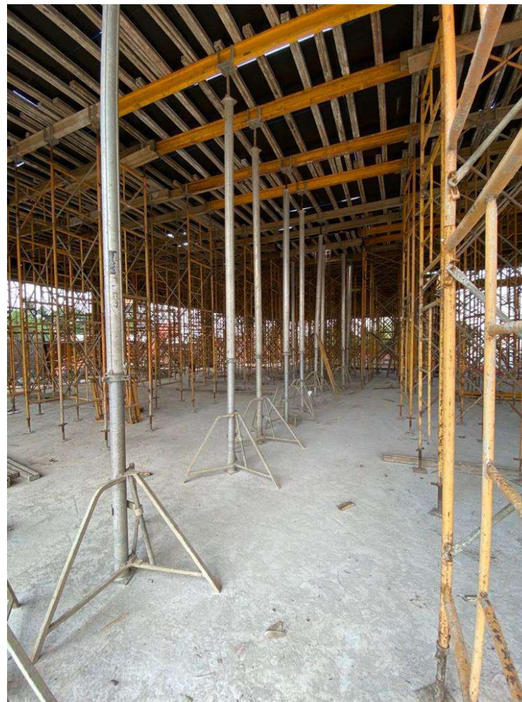
Montagem do Cimbramento da Laje 2º Pav
