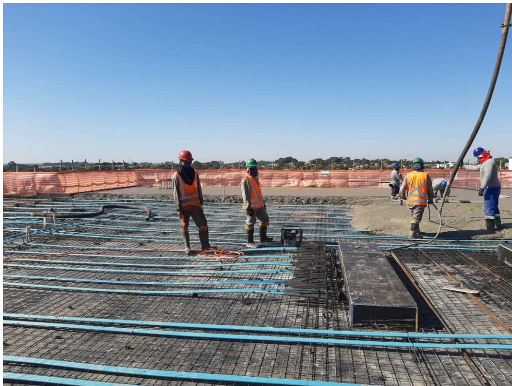
Concretagem Laje 3º Pav.
