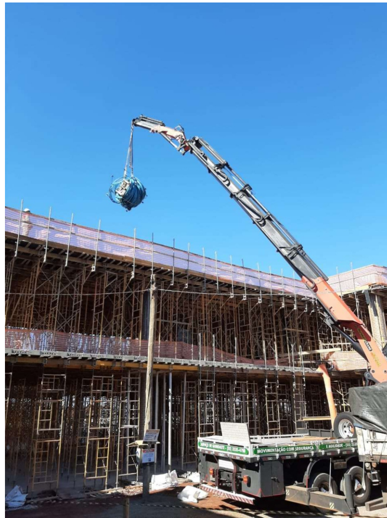
Içamento dos cabos de protensão
