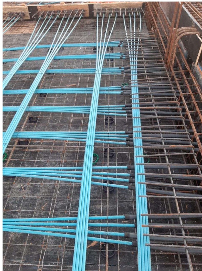
Armadura de fretagem
