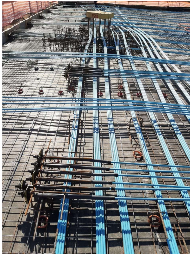
Armadura de fretagem e cabos passivo 3º Pav.
