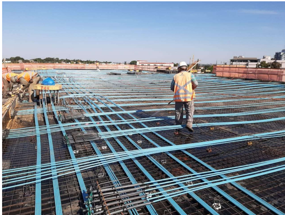
Lavagem da laje para concretagem 3º Pav
