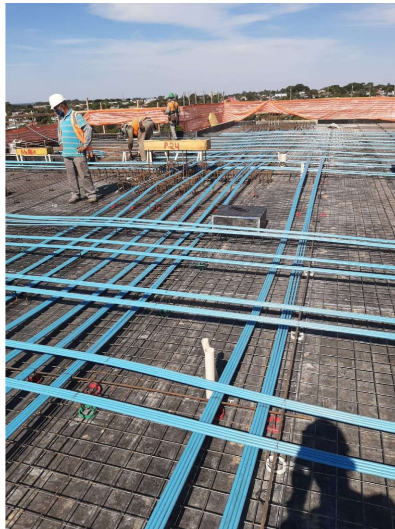
Cabos transversais e longitudinais 3º Pav
