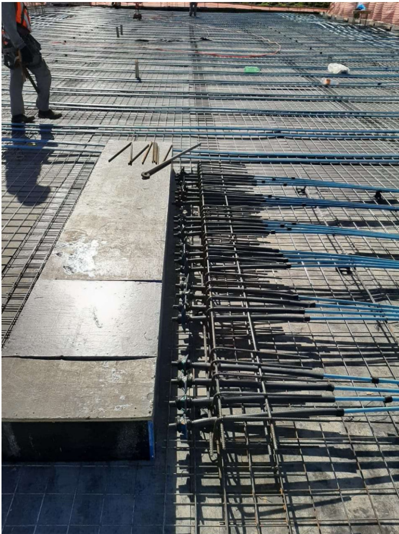
Armadura de fretagem e cabos passivo 3º Pav.
