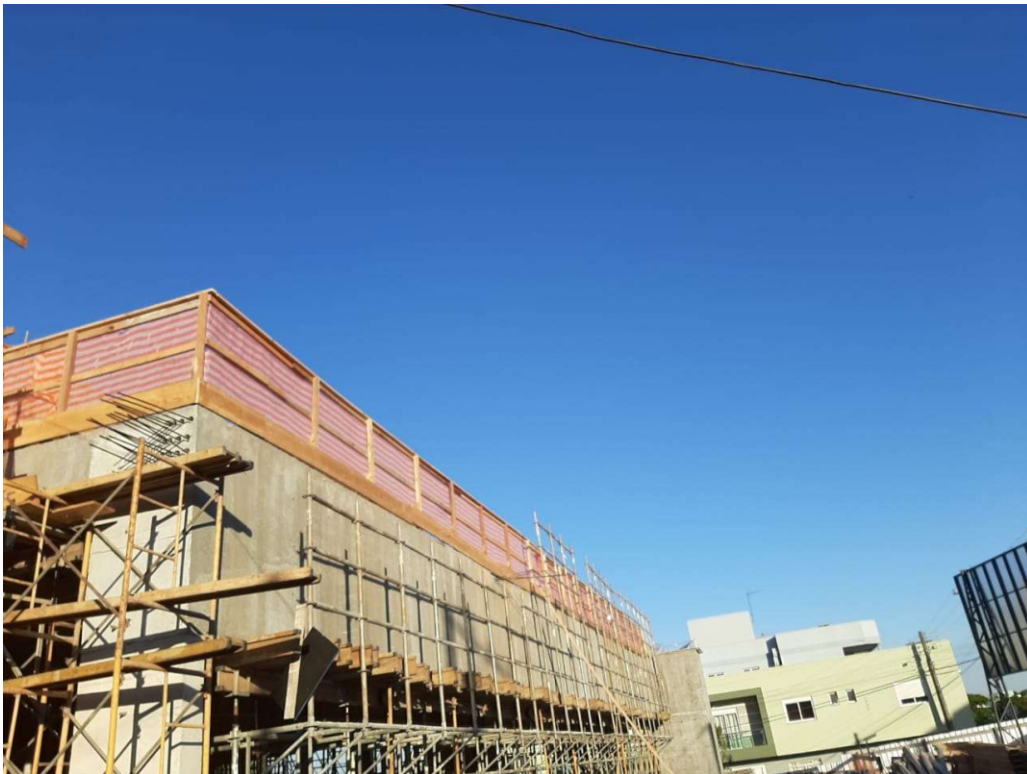
Manutenção do Guarda-corpo de perímetro
