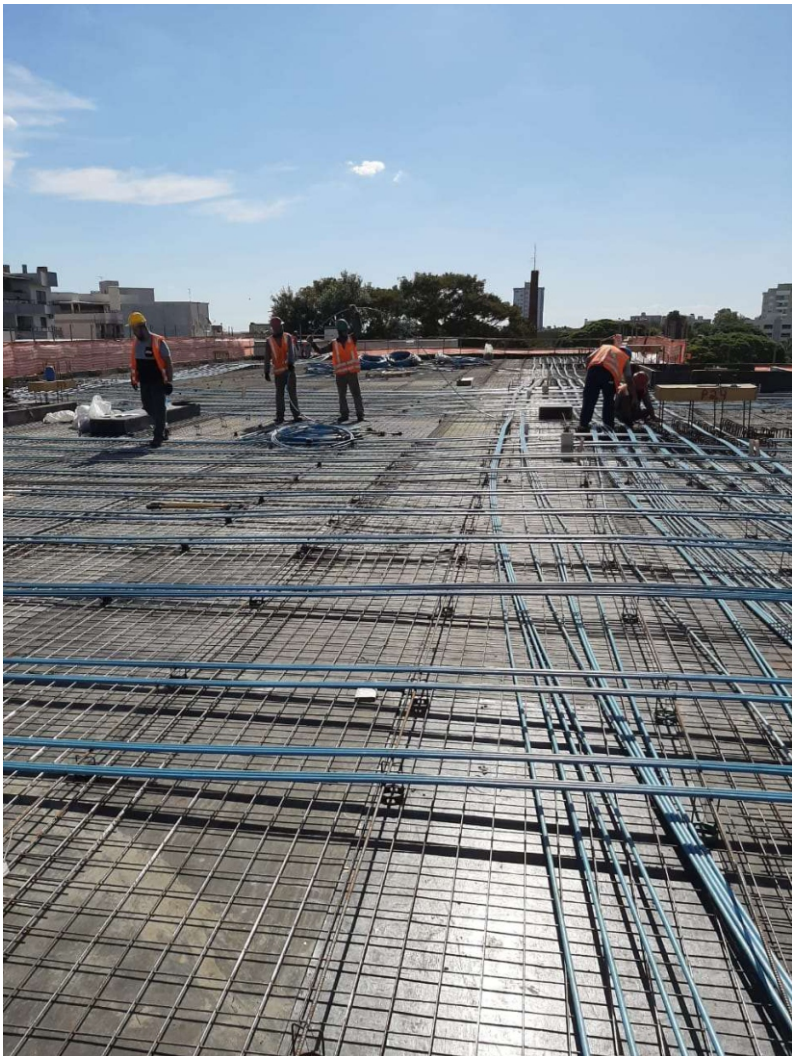
Cabos transversais e longitudinais 3º Pav
