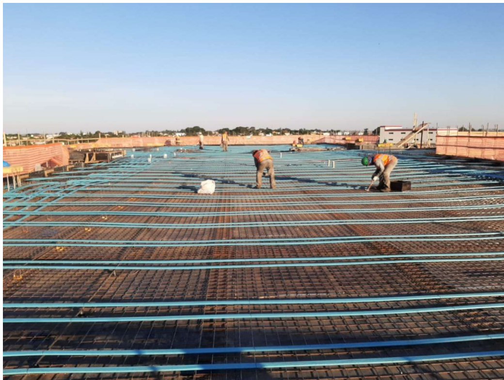
Acabamento dos cabos transversais 3º Pav.
