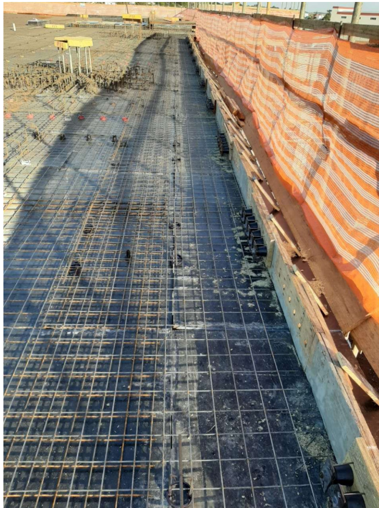
Laje 3º Pav com as ancoragens instaladas
