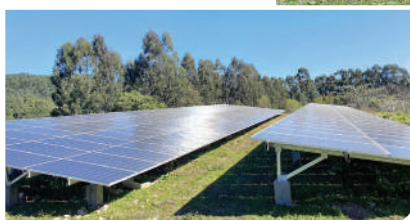
Família financiou a instalação de 198 painéis fotovoltaicos
